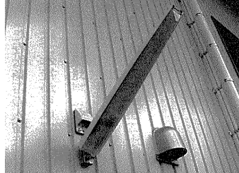
外壁にLED証明を設置
