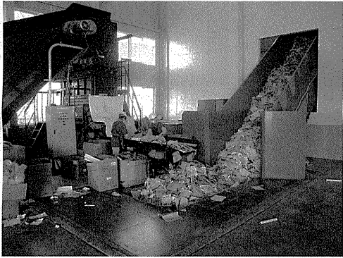
ペーラーの周りを壁で囲い、防音・防振対策を施す
